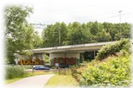
Spoorwegviaduct over de A59
